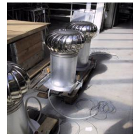
DÆKRØR er egen-levering! Kan købes hos blikkenslagere eller hos Lindab. Eksempel på dækrør enten til skrånende tag eller fladt tag. Fodpladen anvendes til fastgørelsen. Over tagpap eller lign. laves huller for afløb for kondensvand.
