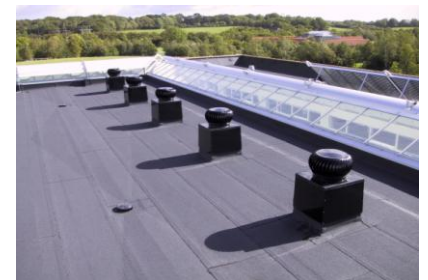
DÆKRØR er egen-levering! Kan købes hos blikkenslagere eller hos Lindab. Eksempel på dækrør enten til skrånende tag eller fladt tag. Fodpladen anvendes til fastgørelsen. Over tagpap eller lign. laves huller for afløb for kondensvand.
