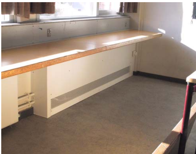
Radiator kabinet indbygget under bord
