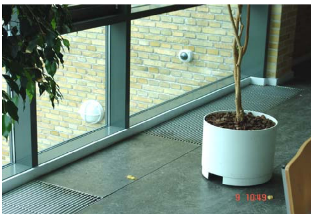
Forvarmning via konvektor grav
