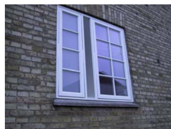
Lodret luftindtag imellem 2 vinduer
