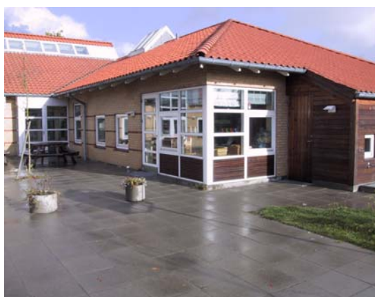
Luftindtag skjult under façade panel
