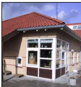
Luft-ind placeret skjult
