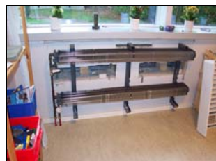
Forvarmning af friskluft
