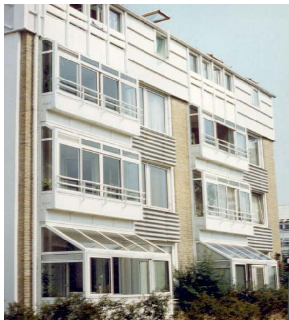
Lejligheder med udluftning af de inddækkede altaner
