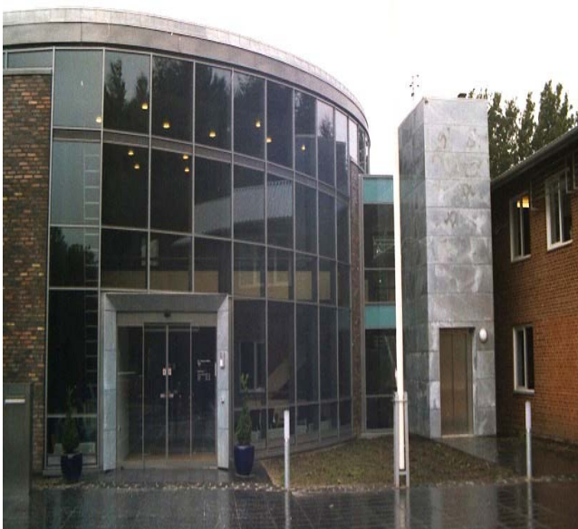
Indgangsparti med friskluft indtag ved jorden og udkast 2/3 oppe på facaden
