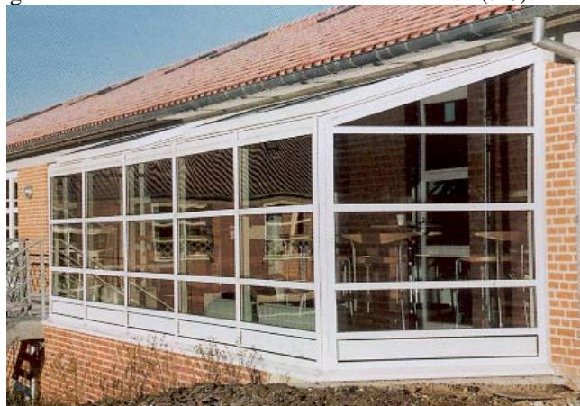
Kantine med friskluft indtag under vinduer
