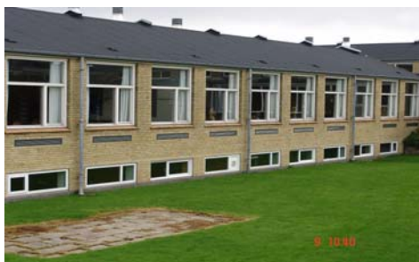
Friskluft indtag i mur
